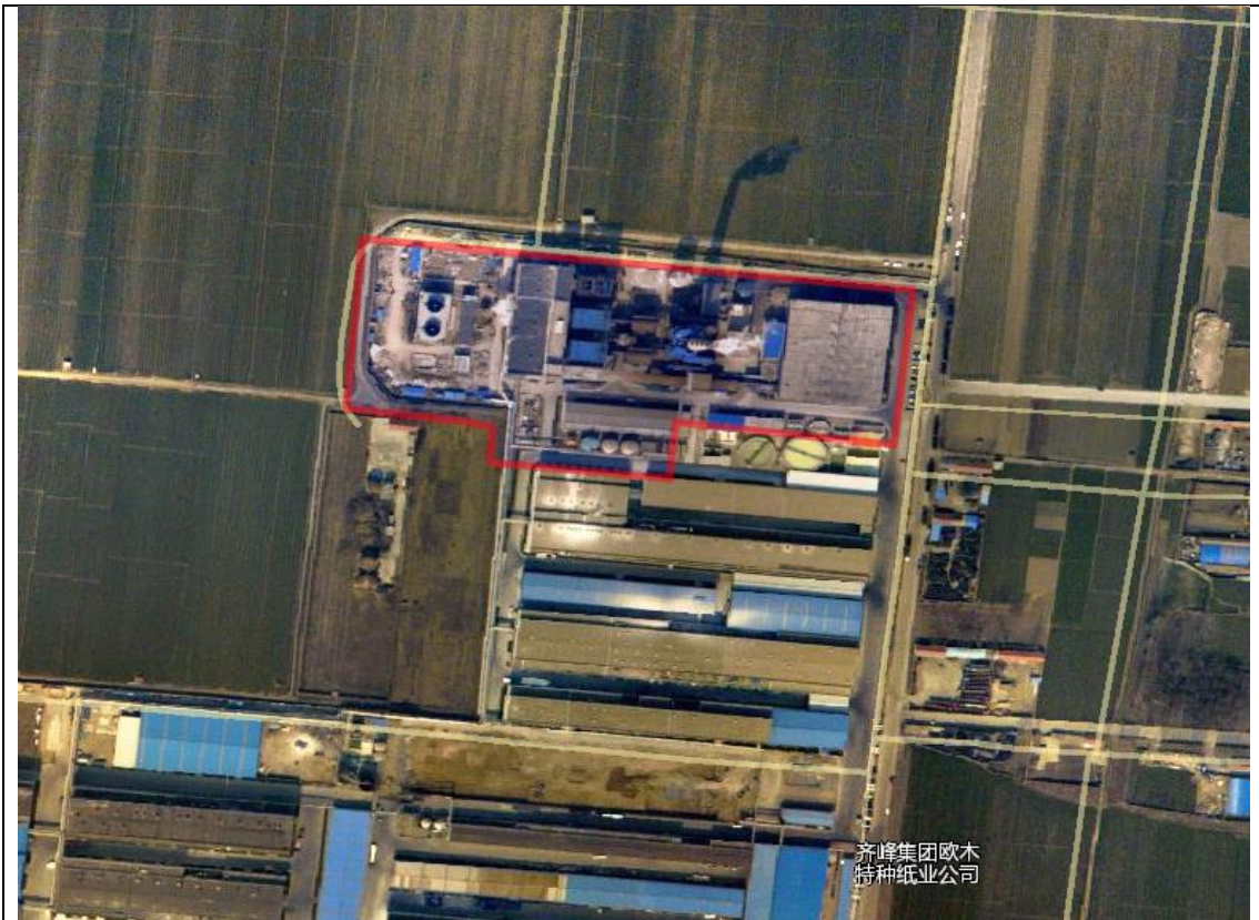
2017年2月份遥感影像照片（施工中）
