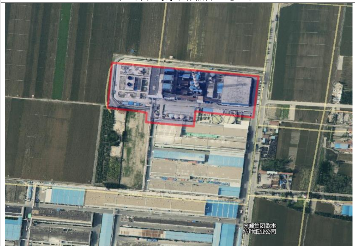
2018年5月份遥感影像照片（建设完成）
