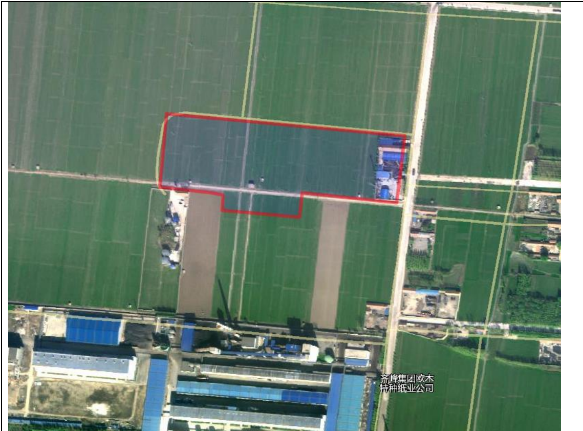
2012年4月份遥感影像照片（施工前）
