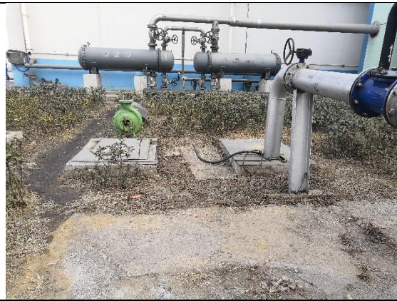
煤场雨水沉淀池
