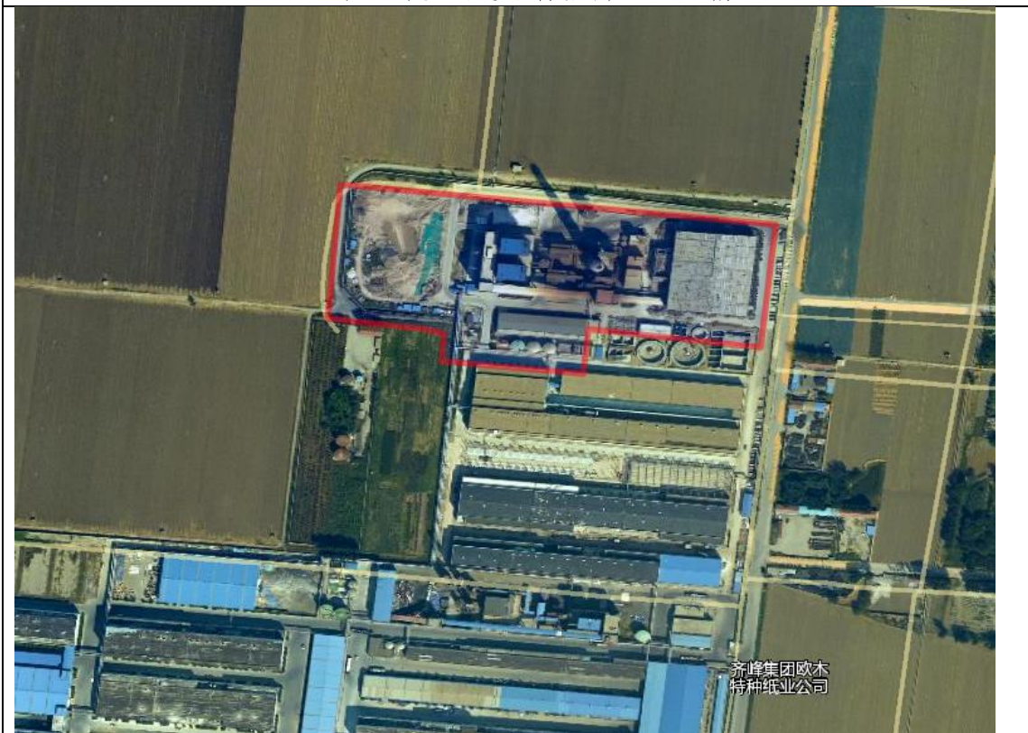
2015年9月份遥感影像照片（施工中）
