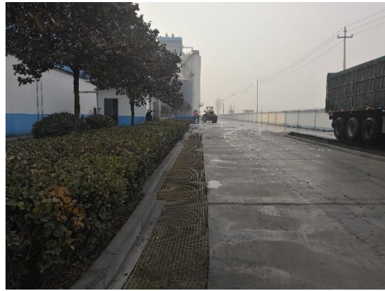
栽植乔灌草、排水暗沟
